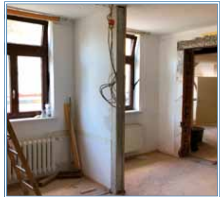
Umbauphase im Hospiz
